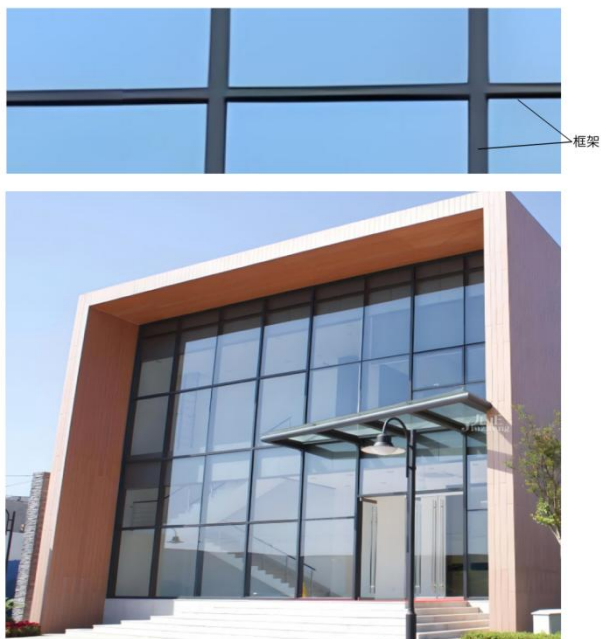
图1.3-2 明框玻璃幕墙
