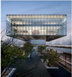
图1.3-4 点支承玻璃幕墙 (西安曲江艺术中心)
