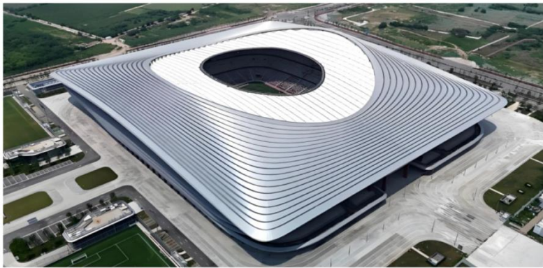
图1.3-7 UHPC人造板幕墙（西安国际足球中心）
