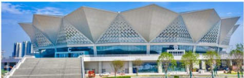
图1.3-5 铝单板金属幕墙 (西安奥体中心体育馆)
