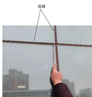
图1.3-1 隐框玻璃幕墙
